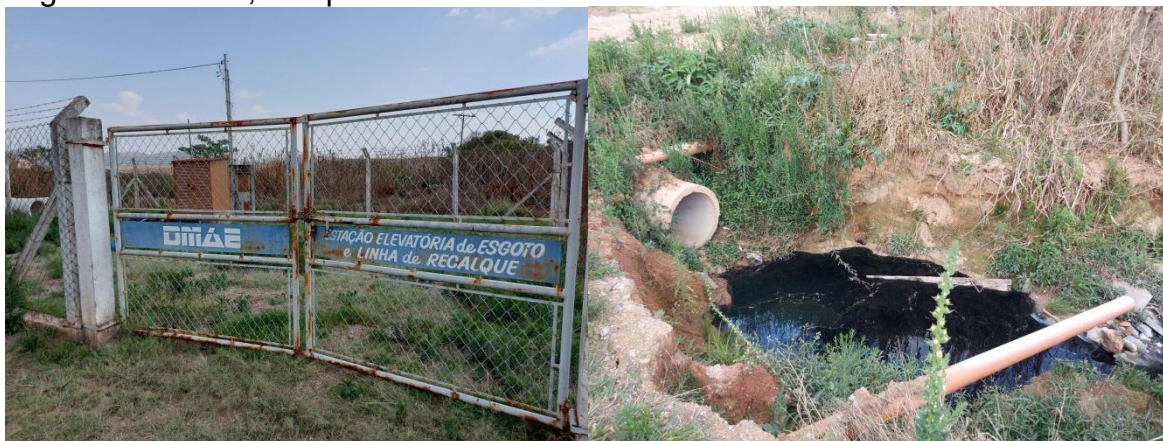
Figura 24 - Presença de esgoto a céu aberto ao lado da estação elevatória de esgoto do DMAE, nas proximidades do P2
